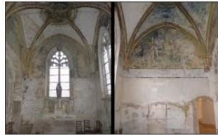
La chapelle de Lugny avant restauration. Photo DR
